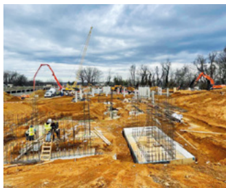
Dann entstehen die ersten Fundamente.
