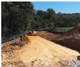
Zuerst wird das Grundstück vorbereitet.
