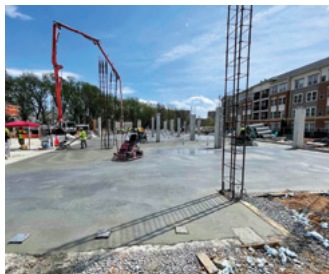
... und eine stabile Bodenplatte gegossen.
