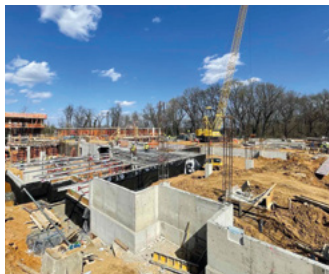
Erste Betonwände werden hochgezogen...
