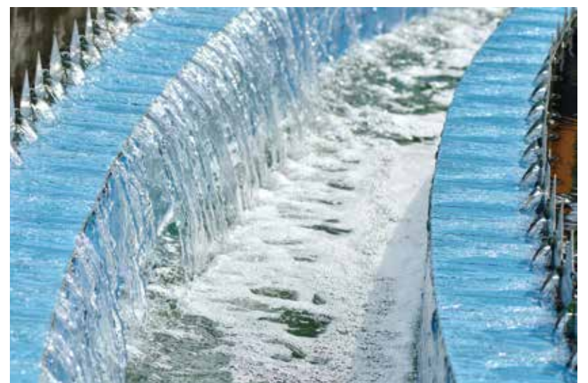
Etwa 120 Liter Trinkwasser verbraucht eine Person in Deutschland täglich.
