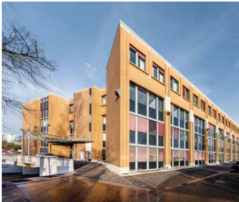
Im Portfolio des EWF 7: ein viergeschossiges Büro- und Ärztehaus in Münster ...
