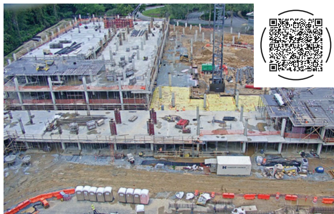
Nur 13 Meilen von der Washingtoner Innenstadt entfernt wächst „NRP Democracy Center“ mit 386 Wohnungen heran.
